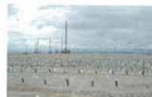
▲ドレーンの打設（地盤改良は、プラスチックボードドレーンを採用した。総延長は1万8,000kmにも及ぶ）
