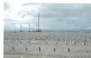
▲ドレーンの打設（地盤改良は、プラスチックボードドレーンを採用した。総延長は1万8,000kmにも及ぶ）
