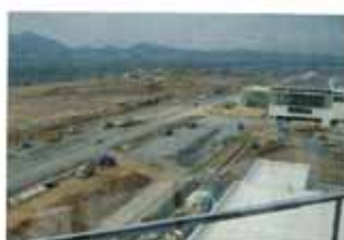
▲ターミナルビル前の道路・駐車場の工事は開港直前まで続く
