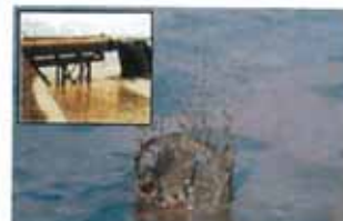
▲浚渫土砂の投入が完了した直後（軟弱な埋込地盤の改良が技術的に最大の課題となった）
