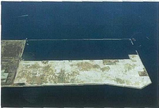
口絵写真—22 地盤改良中の北九州空港用地2工区
