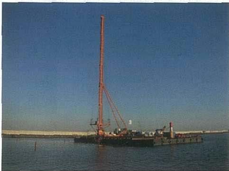
口絵写真—24 試験工事で使用したドレーン打設船
