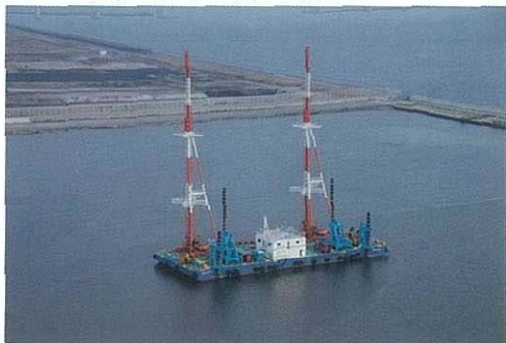
口絵写真—26 本格工事で使用するドレーン打設船
