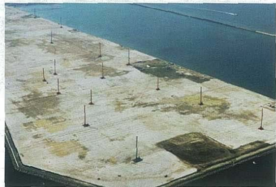
口絵写真—23 地盤改良中の北九州空港用地2工区
